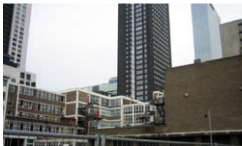
het kantoor MHA, nabij het Weena Rotterdam
