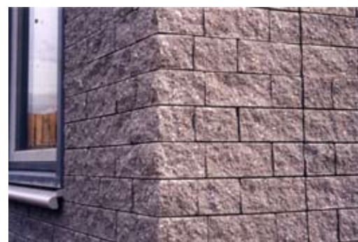
Detail gelijkde betonsteen
