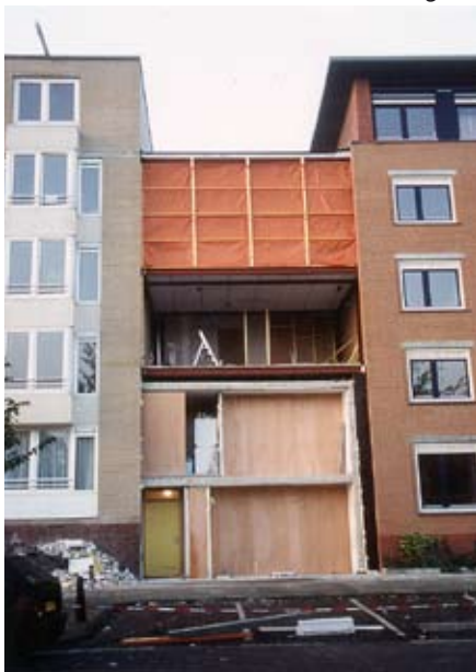
verwijderen oude gevel
